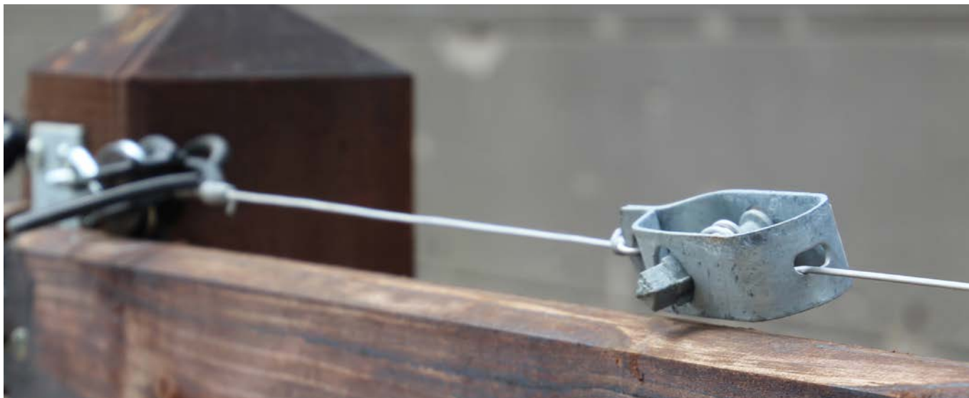
Draadspanner monteren aan een beginpunt
